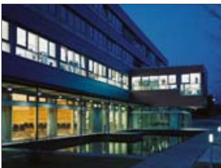
Das neue Institutsgebäude des Fraunhofer IOF
